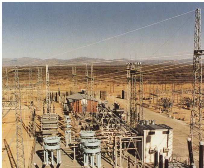
Stacja transformatorowa Omburu z urządzeniami AEG do kompensacji mocy biernej.
